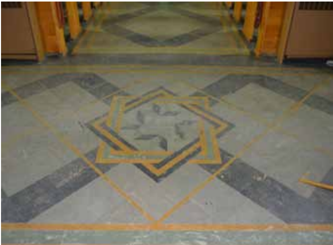
Figure 139 : Les planchers de la nef et du chœur sont recouverts de tuiles de linoléum formant une mosaïque.
