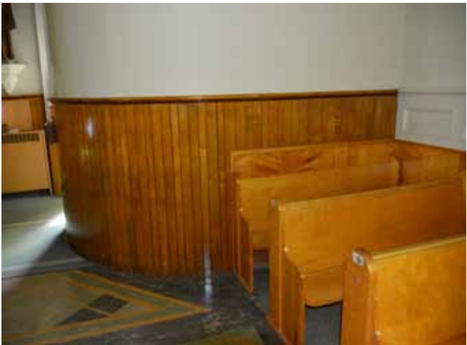
Figure 129 : Un lambrissage de bois verni est présent dans la partie basse des murs. Il est en bon état.
