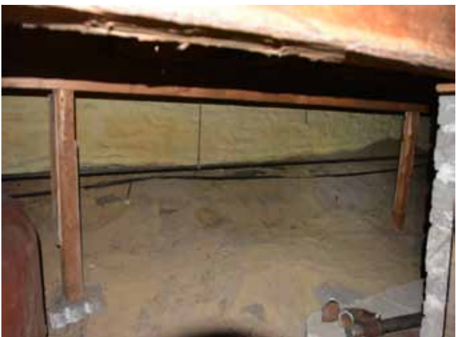
Figure 15 : De l'uréthane a été giclé à l'intérieur des murs du sous-sol, recouvrant l'appareillage de maçonnerie ainsi que les extrémités des solives du plancher et la poutre de rive du rez-de-chaussée.
