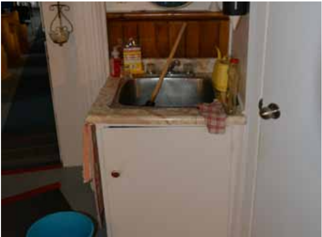
Figure 158 : Un évier de conciergerie est présent vis-à-vis des deux salles de toilettes au sous-sol de la sacristie.
