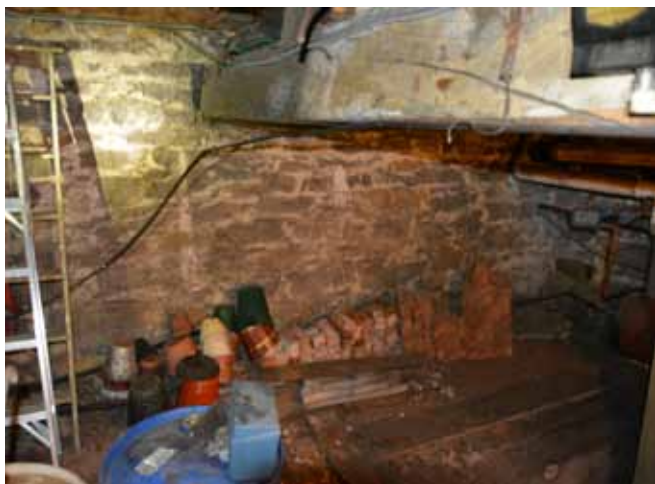
Figure 14 : À l'intérieur, les fondations sont visibles depuis le sous-sol de l'église. Elles sont constituées de maçonnerie traditionnelle de moellons ébauchés.
