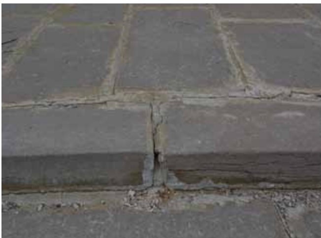
Figure 29 : Il présente plusieurs joints creux ou évidés
