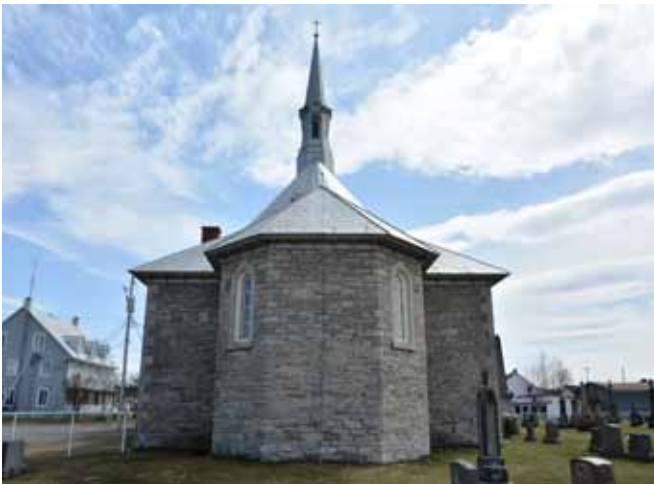
Figure 4 : Façade arrière nord.
