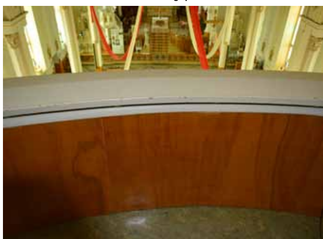
Figure 116 : Les galeries sont protégées par des balustrades pleines constituées de planches de bois.
