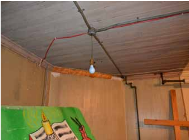
Figure 155 : Le plafond est recouvert d'un lambris de bois peint.
