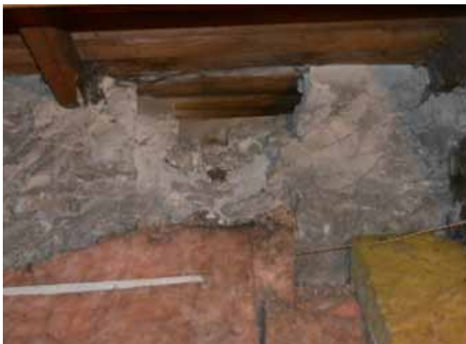
Figure 101 : La ventilation de l'entretait est assurée par des ouvertures au sommet des murs de maçonnerie
