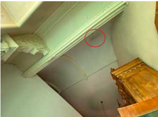
Figure 145 : La finition de la voûte de la sacristie est composée d'une couche de plâtre peint.
