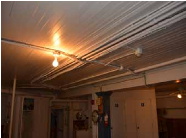
Figure 154 : Le plafond est recouvert d'un lambris de bois peint.
