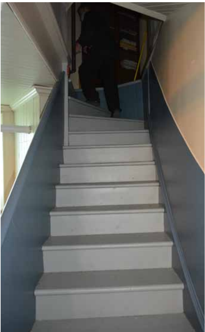
Figure 125 : Un escalier en bois à quart tournant permet de circuler entre les deux niveaux de la sacristie..
