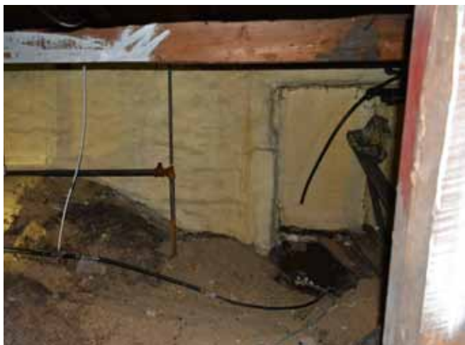
Figure 16 : De l'uréthane a été giclé à l'intérieur des murs du sous-sol, recouvrant l'appareillage de maçonnerie ainsi que les extrémités des solives du plancher et la poutre de rive du rez-de-chaussée.
