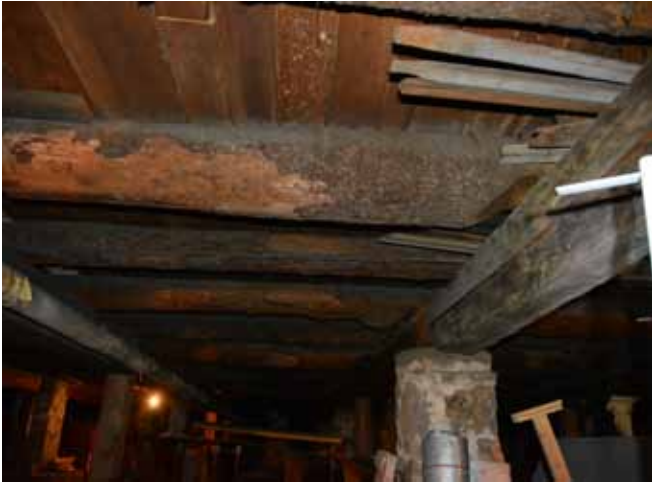
Figure 37 : Les poutres secondaires sont constituées de grumes.
