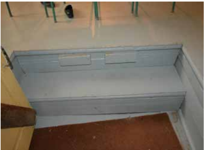
Figure 127 : Au sous-sol de la sacristie, un petit emmarchement constitué d'une marche et de deux contremarches en bois peint permet de descendre au niveau du sous-sol de la nef.
