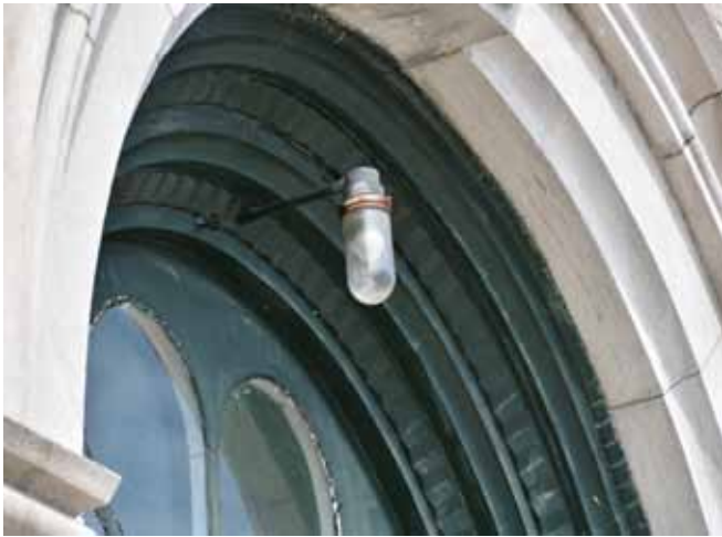
Figure 171 : Des luminaires en métal de style industriel sont fixés sur l'imposte au-dessus des portes de la façade avant.
