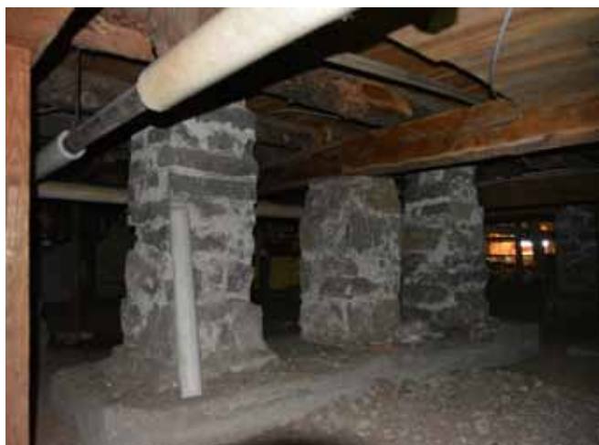
Figure 20 : Trois piliers près du centre de l'église reposent sur une semelle de béton en bon état.
