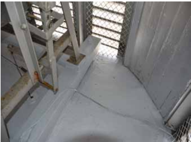
Figure 109 : Le plancher des cloches est recouvert de tôle soudée. La peinture est en bon état. L'expertise visuelle du plancher des cloches témoigne qu'il est en bon état.
