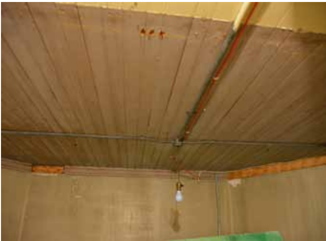
Figure 156 : Le plafond est recouvert d'un lambris de bois peint.
