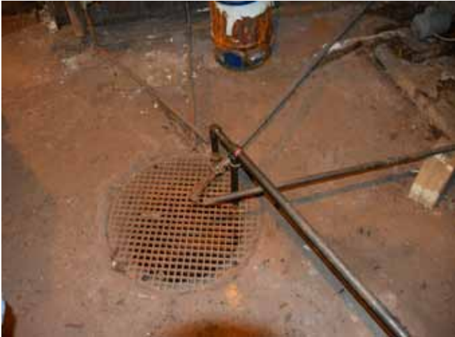
Figure 33 : Un puits refermé par une grille de puisard est présent au fond de la fosse. Un certain nombre de tuyaux parcourent le sous-sol et se déversent sur la grille.
