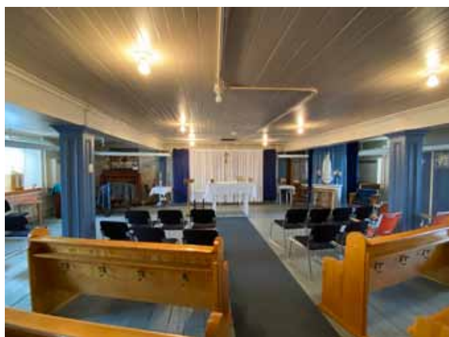
Figure 114 : La grande salle au sous-sol de la sacristie a été préservée. La finition des murs et des plafonds est constituée de lattes de bois peintes.
