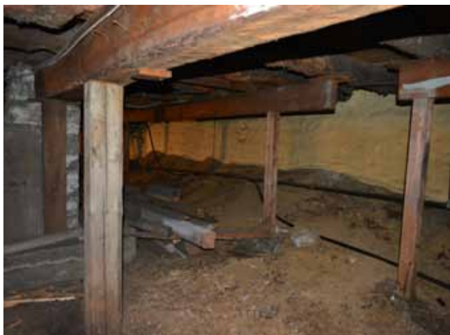
Figure 41 : Certaines grumes sont également supportées par des poutres additionnelles supportées par des poteaux de bois de section carrée entre les poutres maîtresses.
