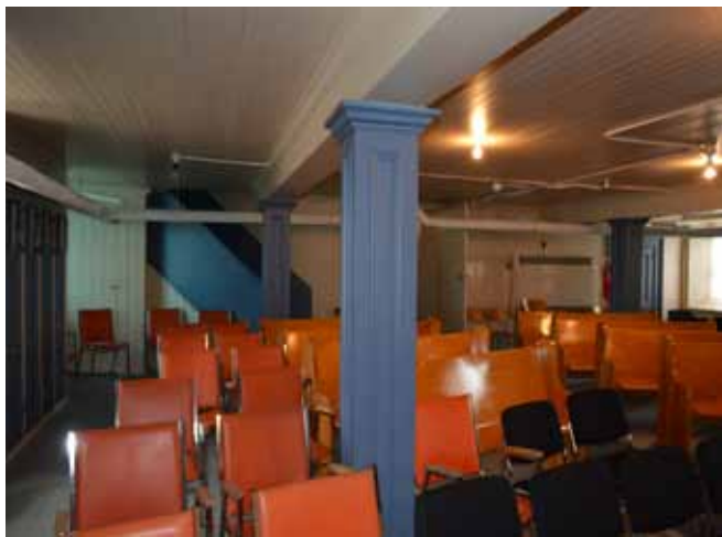
Figure 43 : La structure de plancher de la sacristie est constituée d'un platelage reposant sur deux poutres parallèles à l'axe de la sacristie reposant sur des colonnes de bois.
