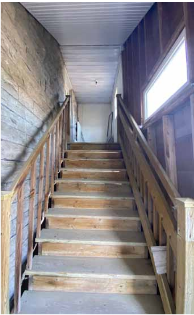
Figure 45 : Une porte sur un palier supporté par des poteaux métalliques et protégé par un tambour donne accès directement au rez-de-chaussée de la sacristie depuis la façade est. Ce palier est accessible par un escalier de bois laissé à nu lui-même protégé par une structure de bois.
