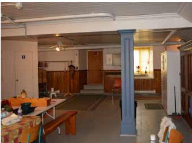
Figure 42 : Le plancher du sous-sol de la sacristie est recouvert de planches de contreplaqué peintes. Celui-ci est probablement constitué d'une dalle sur sol.
