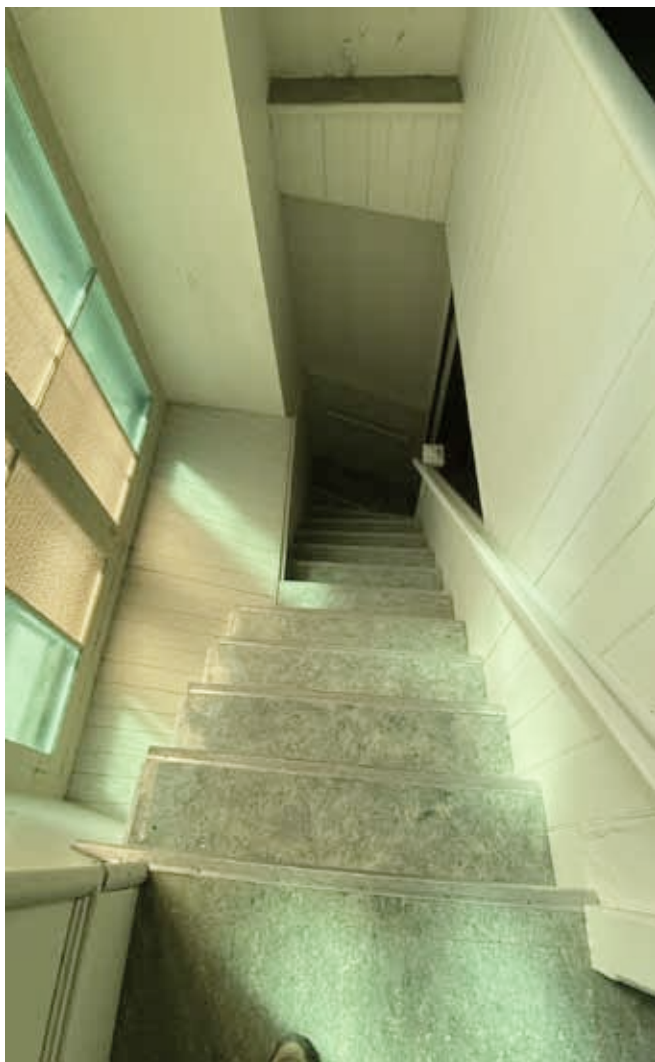
Figure 124 : Un escalier à volée droite mène du premier niveau de la galerie arrière au second niveau où se situe l'orgue.
