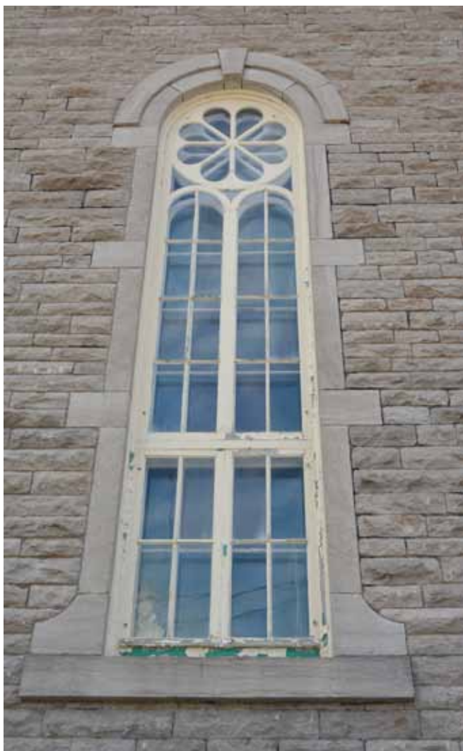
Figure 82 : L'église possède 23 grandes fenêtres à arc en plein cintre constituées de deux baies surmontées par une rosace, soit 3 sur la façade avant, 6 par façade latérale et 1 de chaque côté du chœur.
