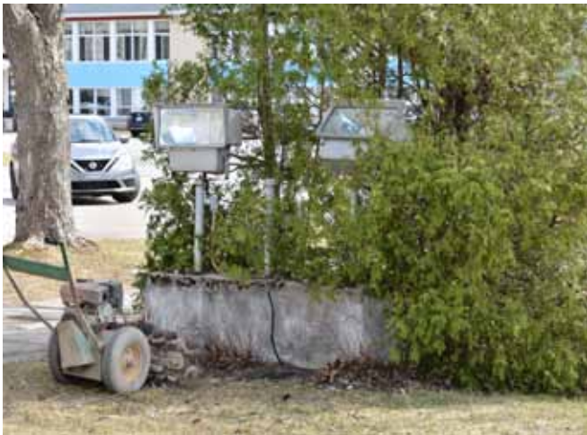
Figure 203 : Des projecteurs en métal posées sur un socle de ciment éclairent la façade principale.
