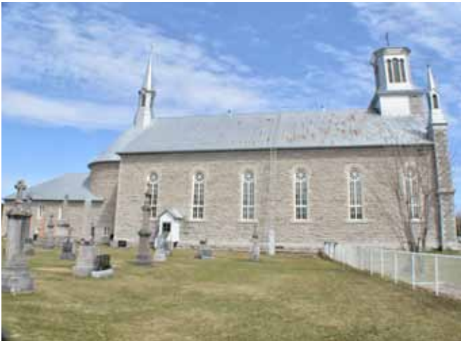
Figure 3 : Façade latérale ouest.
