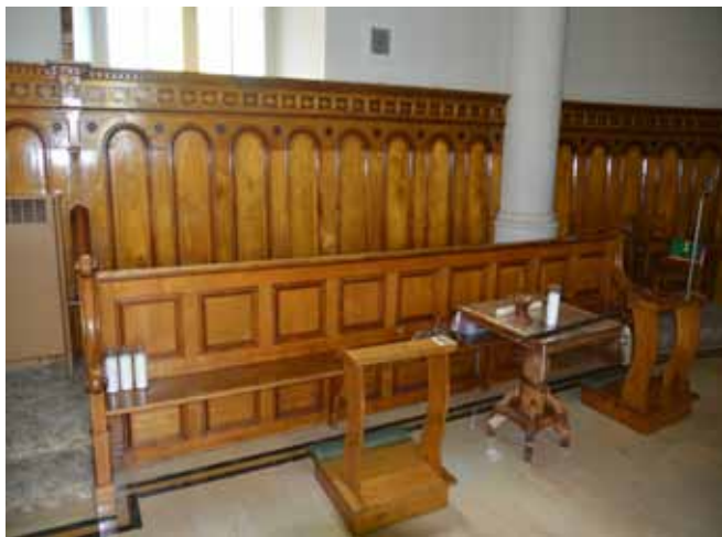
Figure 130 : Dans le chœur, le lambrisage est orné de moulurations ce qui témoigne du savoir-faire des artisans du bois de la région et lui confère une valeur patrimoniale certaine.
