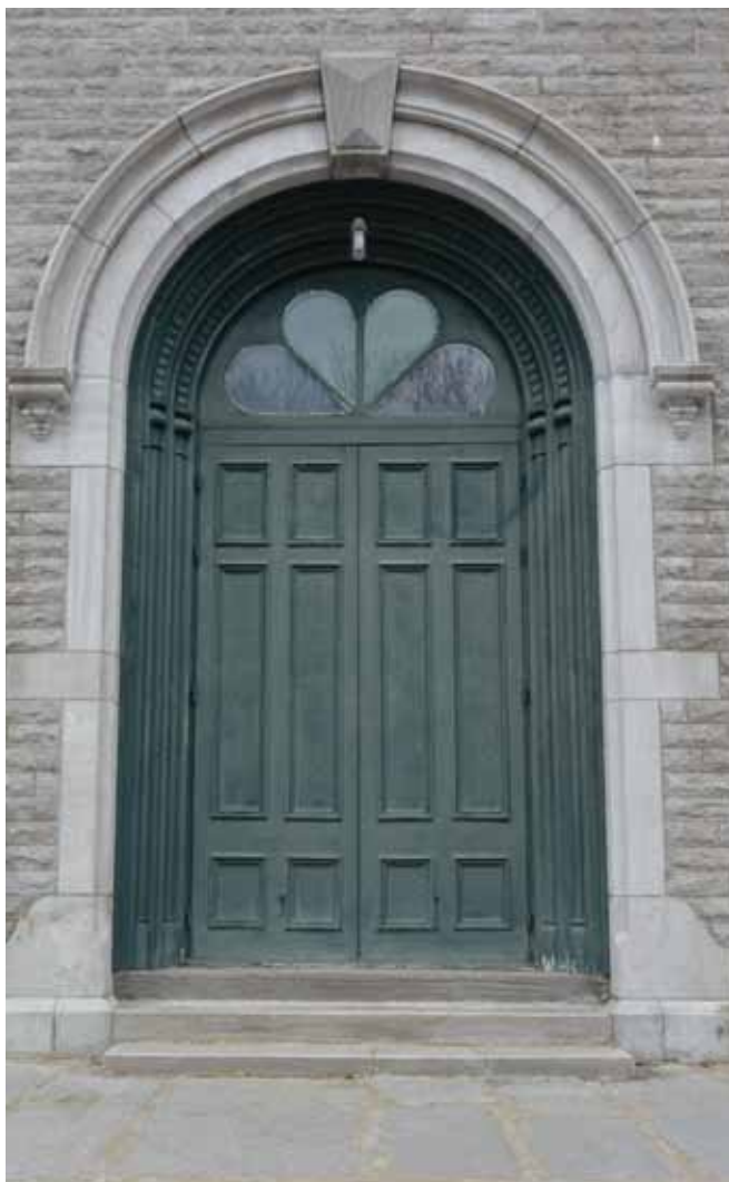
Figure 89 : Les trois portes de la façade principale sont en bois verni à caissons. La porte centrale est à doubles battants.
