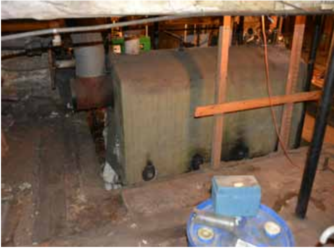
Figure 32 : Des traces d'efflorescence sont visibles.
