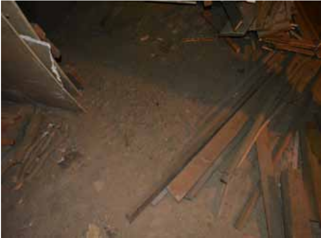
Figure 34 : Le sol sous la nef est en terre battue. Au moment de la visite d'expertise, le taux d'humidité était peu élevé.
