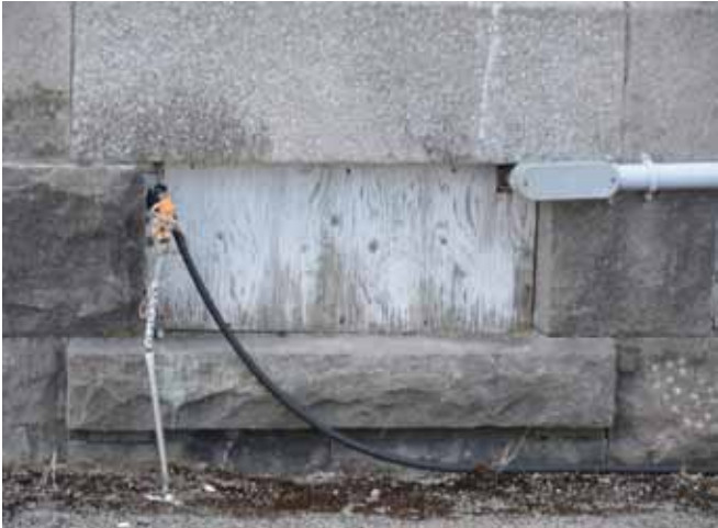
Figure 88 : Un soupirail a été transformé pour accueillir l'entrée de cave du côté ouest et un second, aussi du côté ouest, a été condamné par une planche de contreplaqué.
