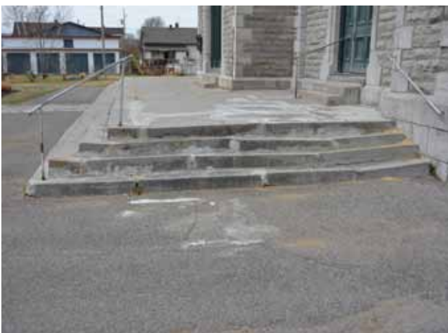
Figure 25 : Un parvis en pierre fait toute la largeur de la façade principale. Le parvis est construit sur du sable, ce qui explique l'affaissement de certaines pierres.
