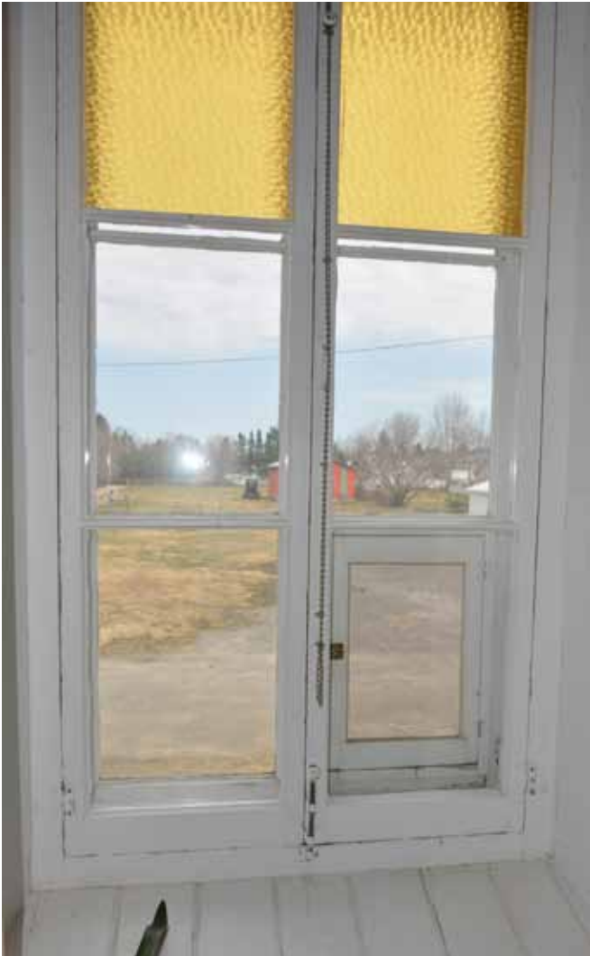
Figure 86 : Les fenêtres intérieures sont généralement en bon état.
