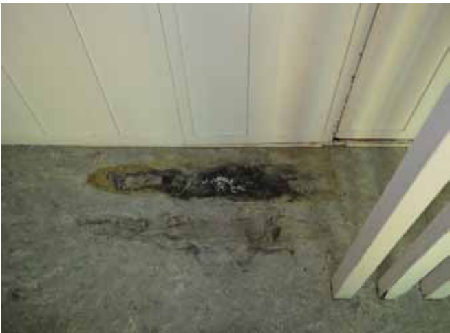
Figure 141 : Sur la galerie arrière, des infiltrations d'eau vis-à-vis du clocher ont dégradé certaines tuiles.
