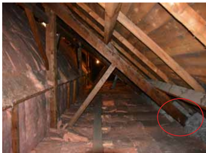
Figure 49 : Les arbalétriers des fermes et les chevrons sont encastés dans la maçonnerie à la tête des murs extérieurs.
