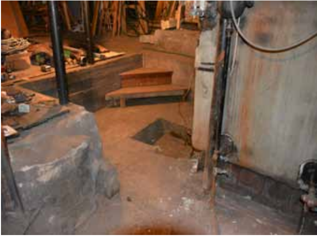
Figure 31 : Une fosse a été creusée à l'avant de l'église pour le système de chauffage. La fosse est formée de murets de soutènement en béton et son sol est formé d'une dalle de béton.
