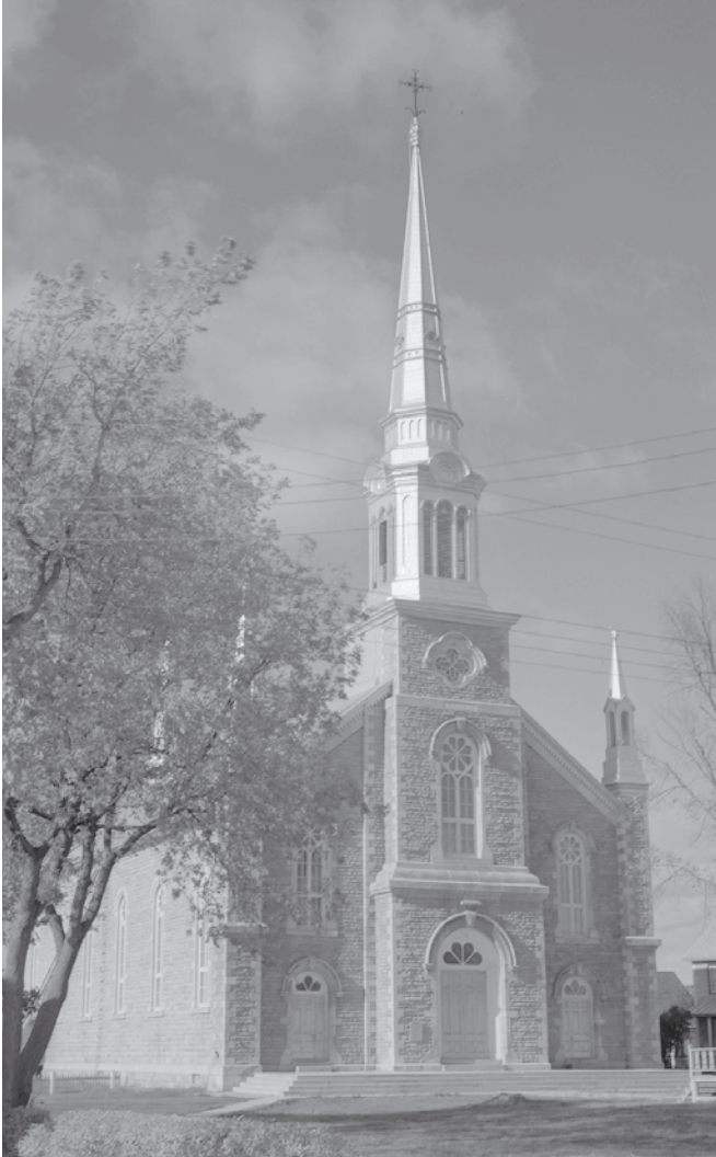
Figure 9 : Photographie de l'église en 1953 par J.W. Michaud. Source : BAnQ Québec - Fonds Ministère de la Culture et des Communications - E6S7SS1P96781.
