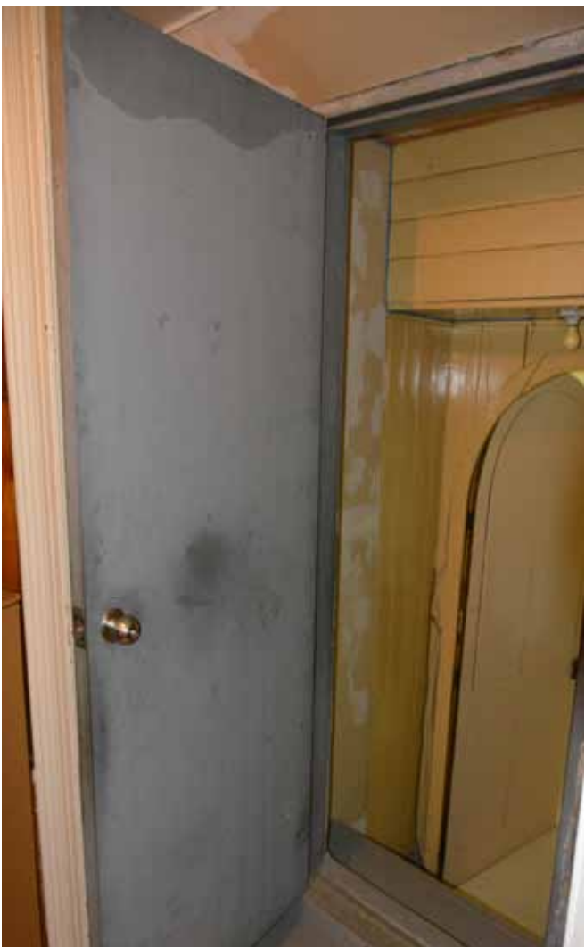
Figure 119 : La porte entre le chœur et l'embranchement menant à la sacristie, via la porte aménagée dans le chasublier, est munie d'une porte coupe-feu en bon état.
