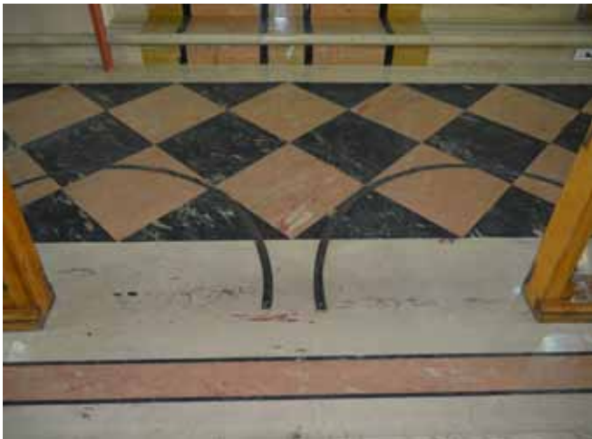
Figure 140 : Les planchers de la nef et du chœur sont recouverts de tuiles de linoléum formant une mosaïque.
