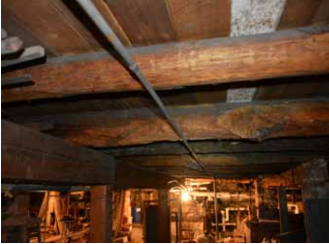
Figure 36 : La structure de plancher de la nef est constituée d'un système de poutres secondaires perpendiculaires au bâtiment et supportées par des poutres maitresses parallèles au bâtiment.
