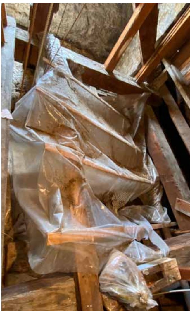
Figure 59 : Des bâches ont été tendues sur la structure de bois du clocher.
