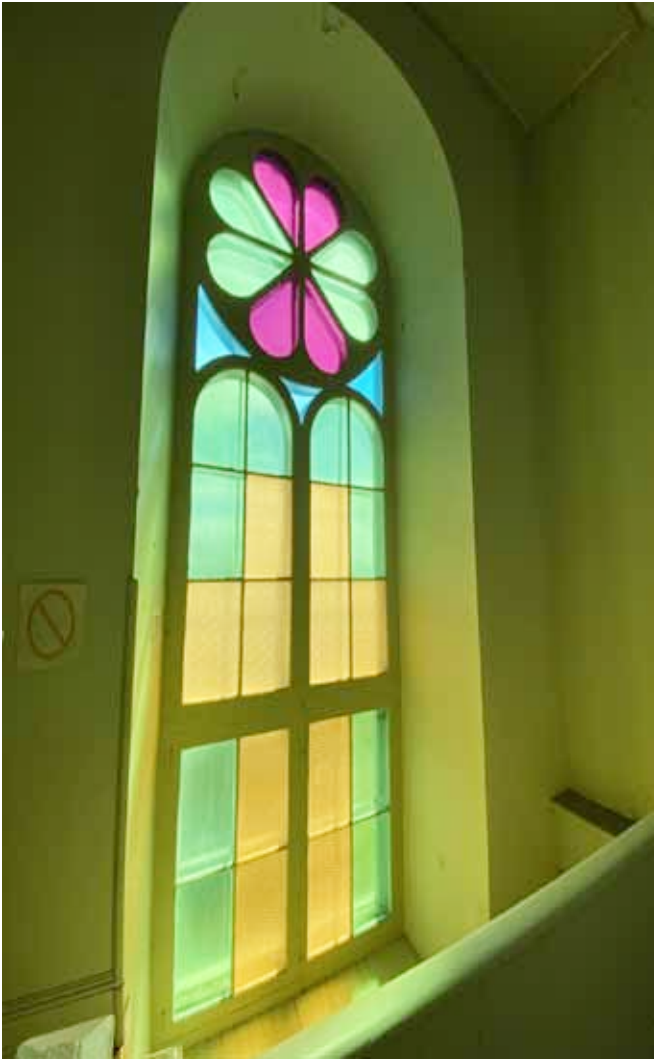
Figure 85 : Dans l'église, les fenêtres intérieures sont munies de verre coloré. Les fenêtres intérieures sont généralement en bon état.
