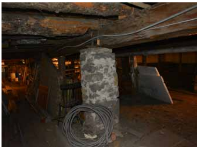
Figure 19 : Les poutres maîtresses du plancher de la nef sont supportées par des piliers de maçonnerie en bon état.
