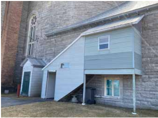
Figure 44 : Une porte sur un palier supporté par des poteaux métalliques et protégé par un tambour donne accès directement au rez-de-chaussée de la sacristie depuis la façade est. Ce palier est accessible par un escalier de bois laissé à nu lui-même protégé par une structure de bois.
