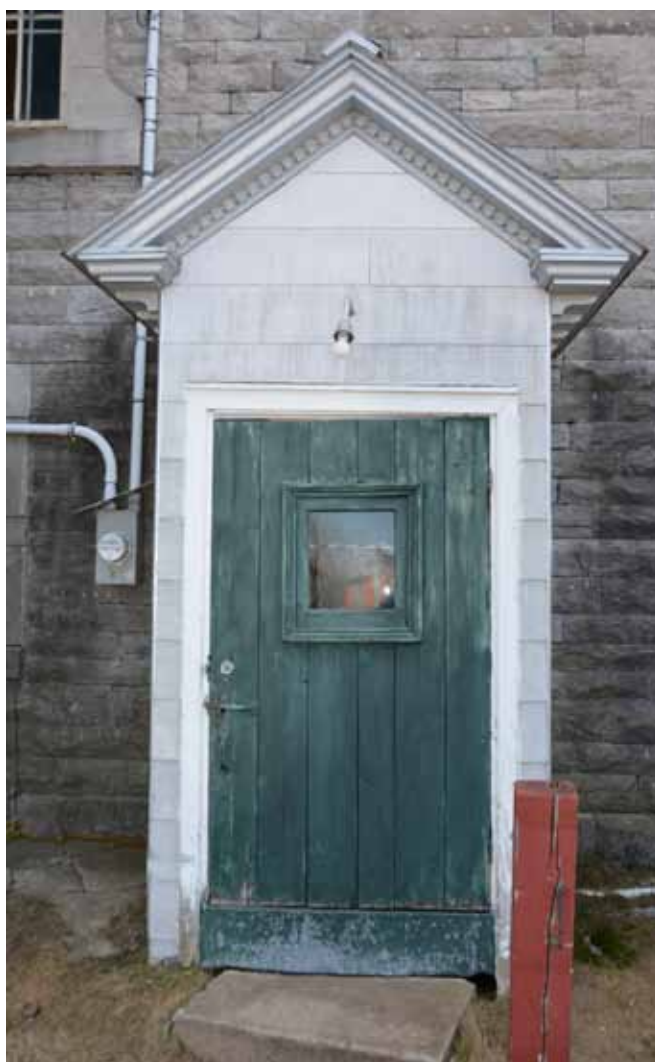
Figure 53 : Un appentis de même facture protège l'accès au sous-sol de la sacristie du côté est. Il est surmonté d'une toiture à deux versants recouverte de tôle et dont les soffites sont ornés de moulures en bois.
