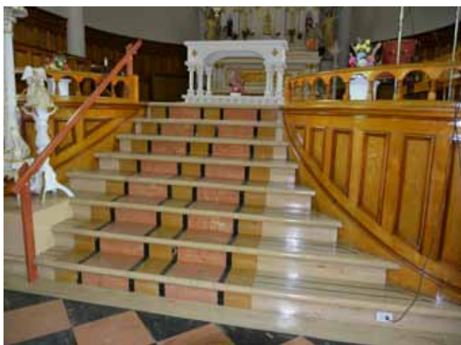
Figure 46 : Le plancher du chœur est composé d'un palier en bois accessible depuis la nef par un escalier en éventail.
