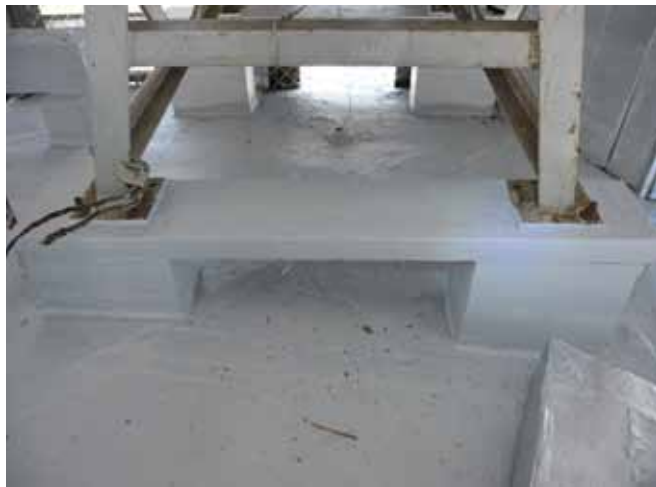
Figure 108 : Le plancher des cloches est recouvert de tôle soudée. La peinture est en bon état. L'expertise visuelle du plancher des cloches témoigne qu'il est en bon état.
