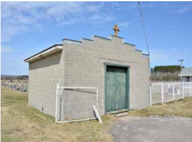
Figure 204 : Un charnier en blocs de béton est présent à l'entrée du cimetière, du côté est de l'église. Sa façade est caractérisée par un parapet à gradins couronné par une croix métallique légèrement rouillée. Il est fermé par une porte à deux battants constitués de planches de bois peintes. La peinture est usée.
