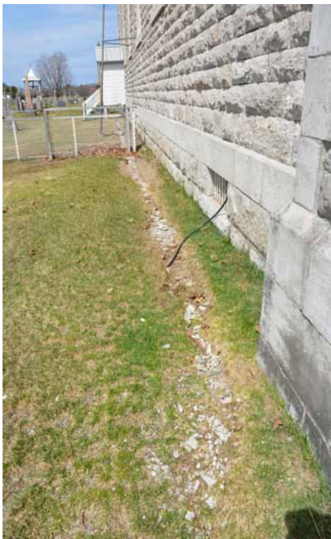
Figure 22 : Du côté ouest, les traces d'un lit de propreté sont toujours visibles. Le gazon a commencé à envahir les pierres.
