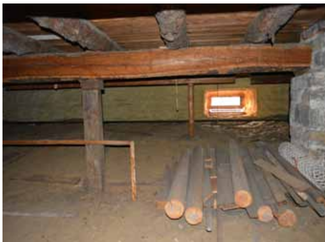
Figure 17 : Certaines poutres ont également été renforcées il y a longtemps par des poteaux de bois de section carrée.
