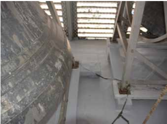
Figure 107 : Le plancher des cloches est recouvert de tôle soudée. La peinture est en bon état. L'expertise visuelle du plancher des cloches témoigne qu'il est en bon état.
