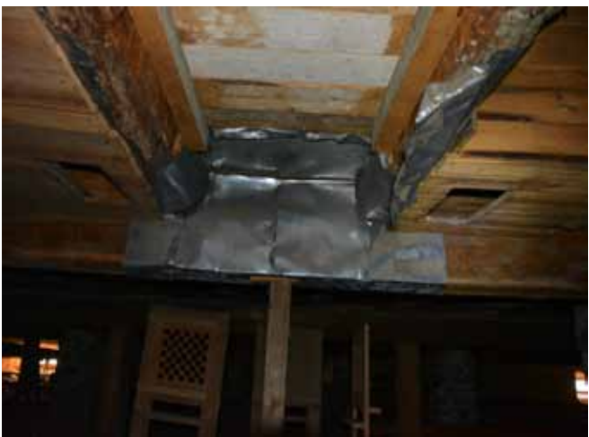
Figure 40 : Vis-à-vis une section plus haute du plafond du sous-sol, l'assemblage de deux poutres maîtresses, une partie des grumes et du platelage ont été recouverts de plaques métalliques.
