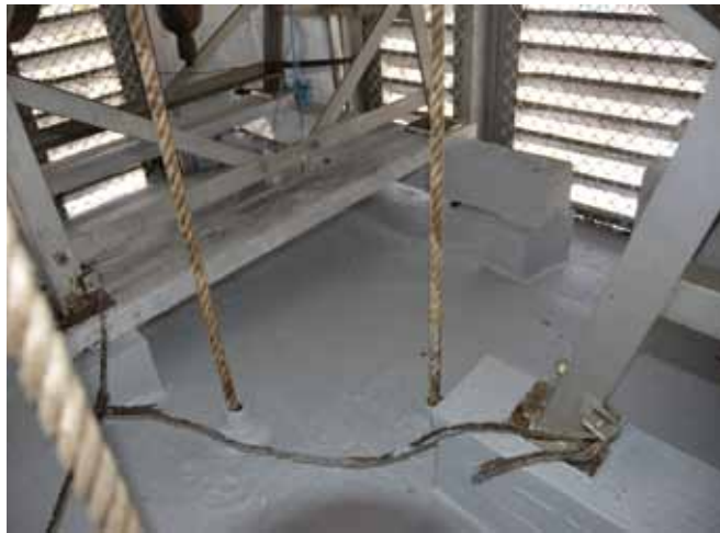
Figure 106 : Le plancher des cloches est recouvert de tôle soudée. La peinture est en bon état. L'expertise visuelle du plancher des cloches témoigne qu'il est en bon état.
