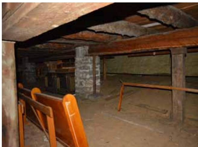
Figure 18 : Les poutres maîtresses du plancher de la nef sont supportées par des piliers de maçonnerie en bon état.
