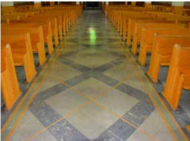
Figure 137 : Les planchers de la nef et du chœur sont recouverts de tuiles de linoléum formant une mosaïque.
