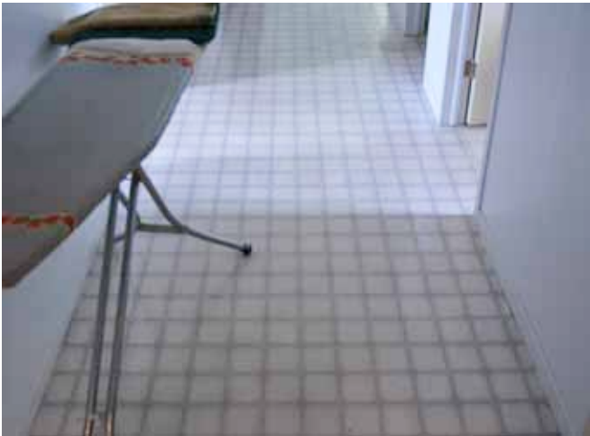
Figure 143 : Le plancher du rez-de-chaussée est recouvert de linoléum également.
