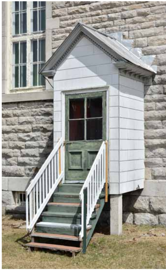
Figure 52 : Un appentis protège l'entrée latérale de l'église sur la façade ouest, entre l'avant-dernière et la dernière travée à l'avant, près du chœur. L'appentis est généralement en bon état. Ses murs sont recouverts de tuiles d'amiante, dont certaines sont cassées.
