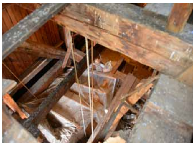
Figure 61 : Des bâches ont été tendues sur la structure de bois du clocher.
