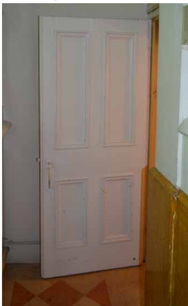
Figure 117 : Les portes intérieures d'origine sont en bois à caissons.
