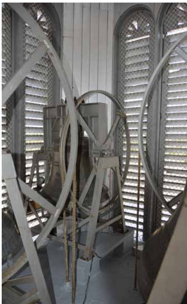
Figure 55 : La lanterne est de plan carré à pans coupés avec trois ouvertures à arc en plein cintre fermées de louveres sur chaque façade.
