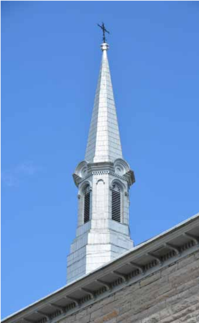
Figure 63 : Un clocheton recouvert de tôle est également situé au faite de la toiture du chœur. Il est en bon état.
