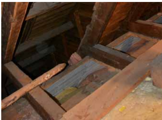
Figure 48 : Les pannes reposent sur des fermes composées d'arbalétriers, un poinçon, un faux-entrait, deux jambettes et de deux contre-fiches.
