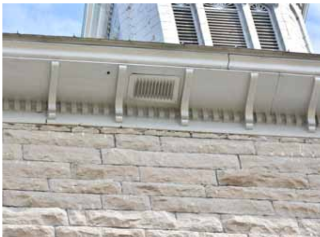
Figure 76 : Les larmiers, ces débords de toiture qui permettent de faire dévier l'eau de pluie de l'église, sont formés de soffites et de fascias, la bande verticale bande sous le bord de toit, en bois. L'entretoit est ventilé au moyen de grilles sur les soffites, c'est-à-dire le revêtement qui recouvre le dessous du larmier.
